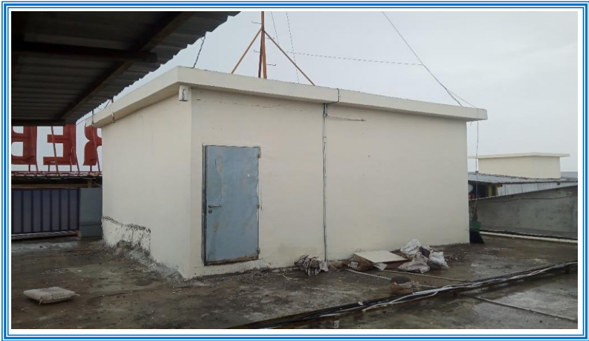
Rumah bed lift/ruang mesin, lt. rooftop
